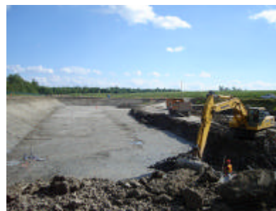
Vue de l'excavation des sols et profilage de la cellule d'enfouissement
