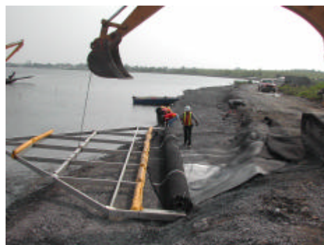
Installation du géotextile
