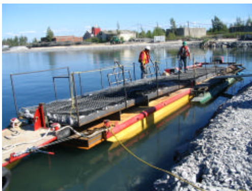
Barge spécialisée dans l'installation de gabions en eau
