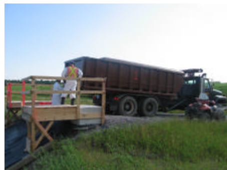
Un conteneur disposé sur une barge mécanisée accumule les sédiments extraits par l'excavatrice. Le conteneur plein est ensuite transporté par camion vers la cellule d'enfouissement.
